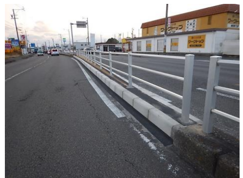
完成閉鎖（施工後）
