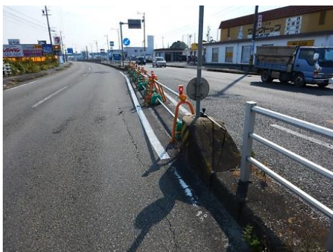
暫定閉鎖（施工前）
