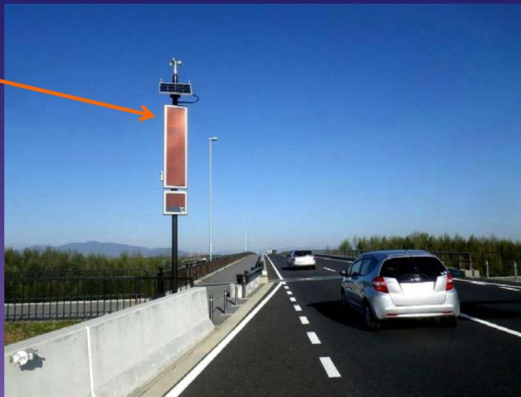
1秒間に10m以上の風速を測定時に「横風注意」を表示。風が10m以下の場合、気温や対面通行など3パターンで表示
