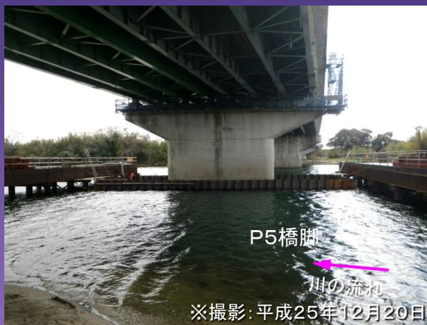
P5橋脚(右上写真)においては、河川内なので材料を輸送するための仮の橋を作り、橋脚の周りを鉄板で締め切り、止水した上で右イメージ図のように橋脚巻立て工事を実施します。
