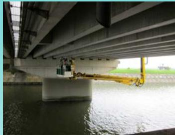
写真は橋梁点検車を用いた点検状況です。
