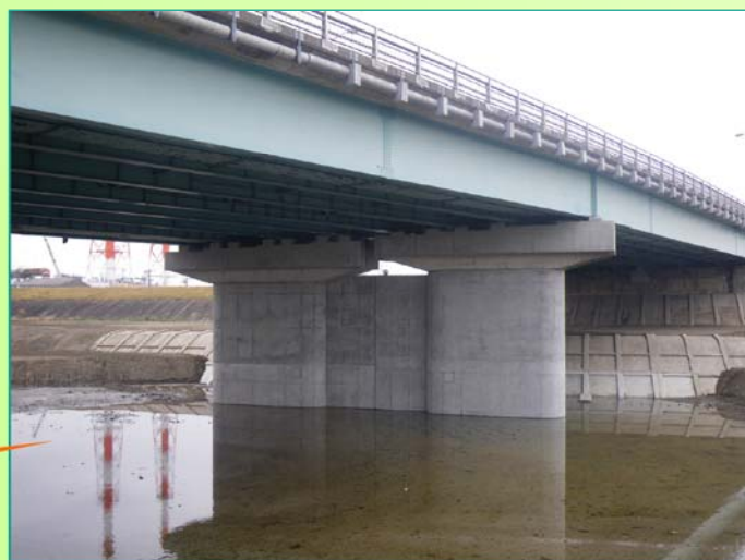
P2 橋脚完成
