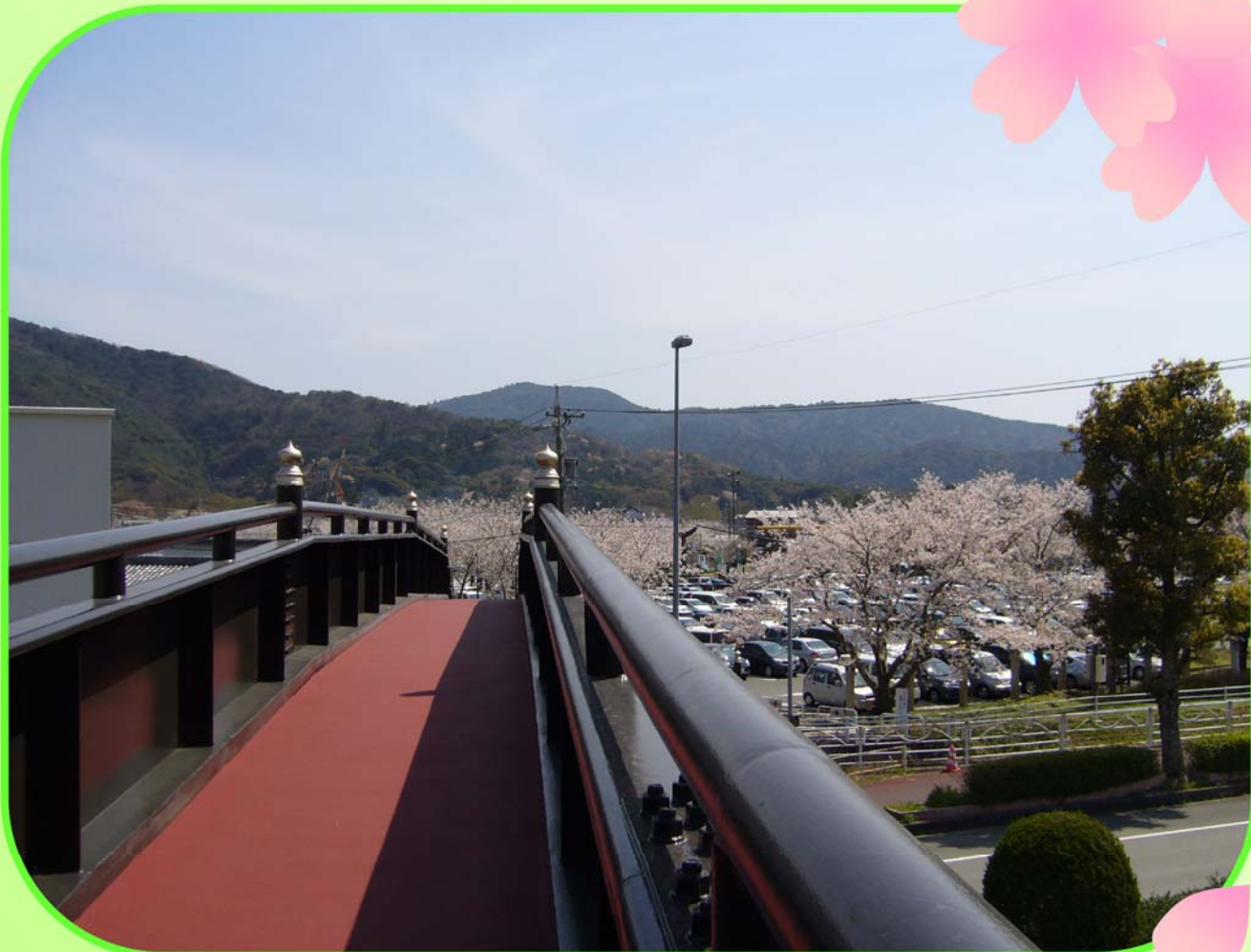
景観に配慮した「浦田歩道橋」
