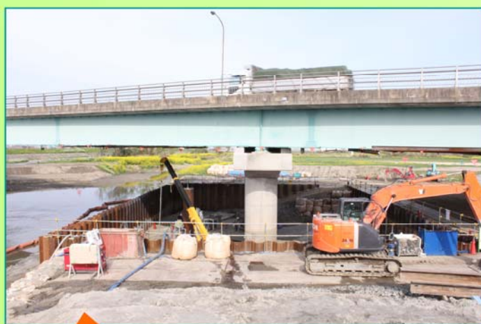
P3 橋脚施工中
