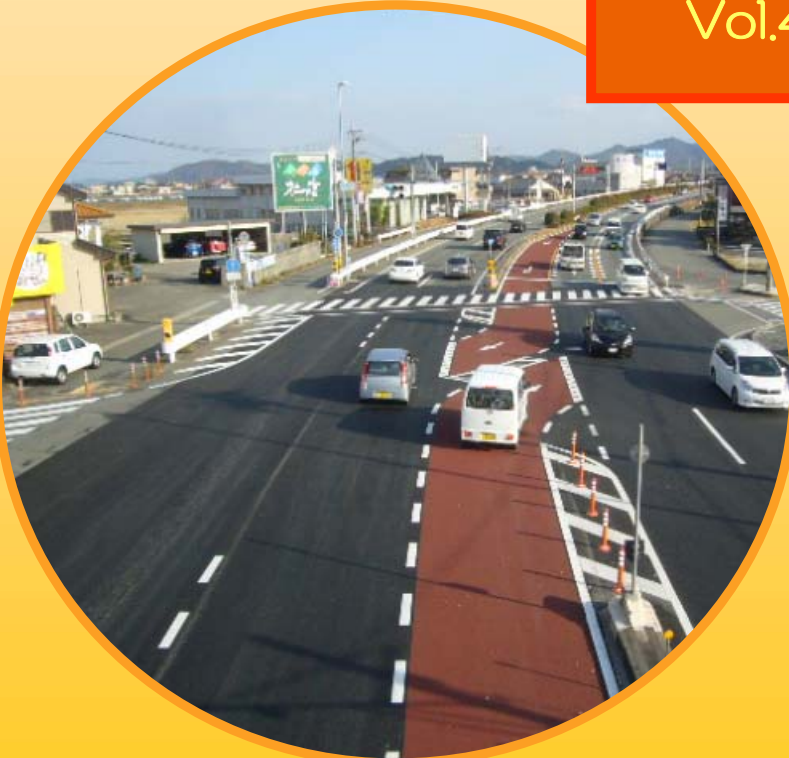
伊勢市田尻交差点(事故対策状況)
