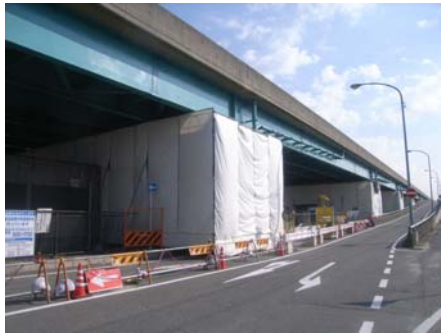
足場設置状況
