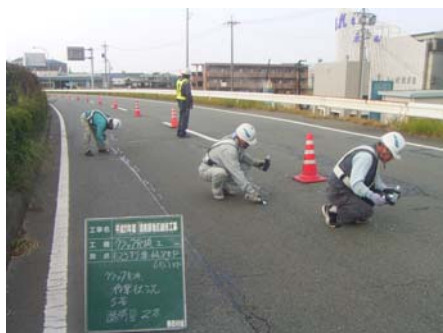
舗装のクラック補修状況
