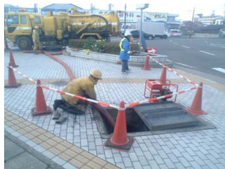
管渠の清掃を行っている状況
