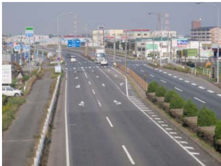
工事着手前(一ノ宮町)
