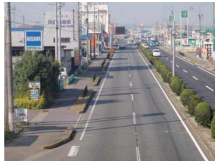
工事着手前(西玉垣町)
