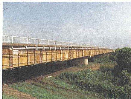
足場設置状況(鈴鹿大橋)
