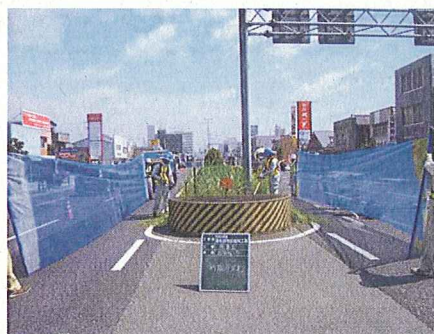
除草作業状況
