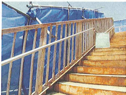
古い塗装の剥ぎ取り状況(上野歩道橋)
