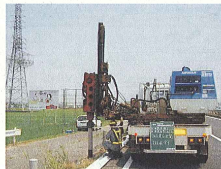
支柱建て込み状況(鈴鹿市)
