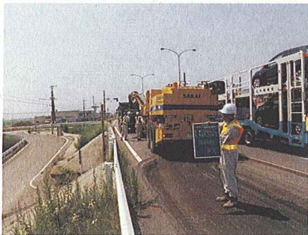
古い舗装を切削機により削っている状況
