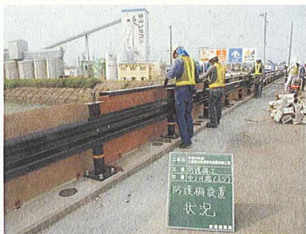
ガードレール組立状況(中ノ川橋)
