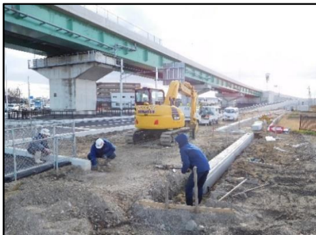
⑯23号玉垣西舗装工事
