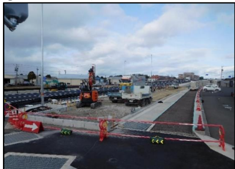
⑭23号安塚舗装工事
