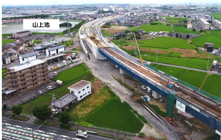
施工箇所②【北玉垣1】 令和4年7月撮影
