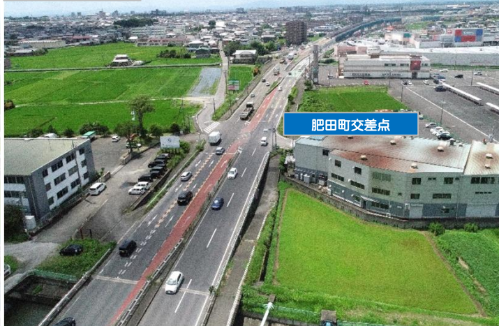
施工箇所① 令和4年7月撮影
