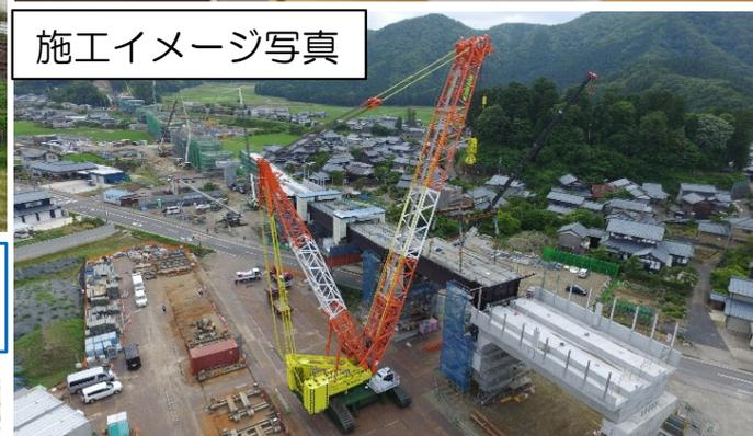
北玉垣町にて伊勢鉄道を跨ぐ橋梁工事が始まります。クレーンで橋桁（長さ 約44.7m、重さ 約49t）を吊り上げて工事を行います。
