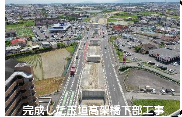
完成した玉垣高架橋下部工事
