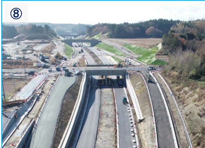
本線部、ランプ部(オン・オフ)、市道部の最終仕上げを行っています。舗装・ガードレール・区画線等を施工していきます。
