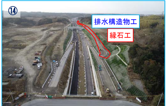
側道(副道)箇所の排水構造物及び縁石を施工中です。来年の1月から舗装の施工を進めていきます。
