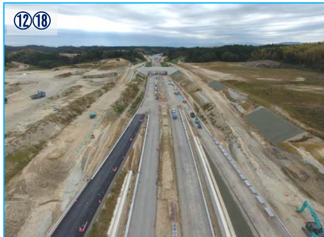
現在、排水構造物工・縁石工・情報ボックス工を施工中です。11月初旬から12月下旬にかけて、舗装を仕上げていきます。
