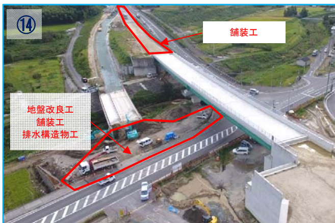
県道交差点付近の地盤改良工・舗装工・排水構造物工を行います。12月のランプ開通に向けて工事を進めています。
