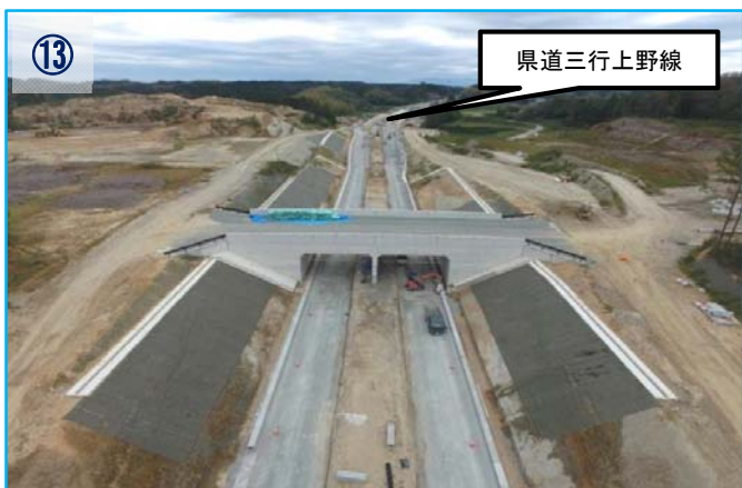
現在、縁石、情報ボックス、照明配管を施工中です。11月より舗装工、三行東交差点で構造物の施工していきます。
