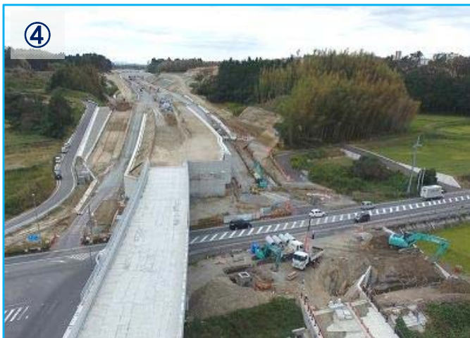
11月は県道三行上野線の横断排水管を施工して、担当工事は終了となります。
