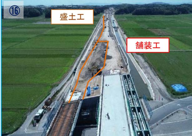
道路土工、踏掛版、排水構造物工を中心に施工を行っております。引き続き、道路土工、舗装工を中心に施工を行います。
