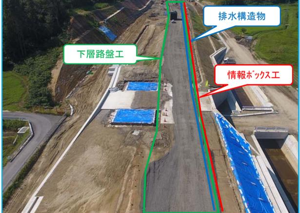
9月に引き続き排水構造物工、下層路盤工、情報ボックス工の施工を進めていきます。
