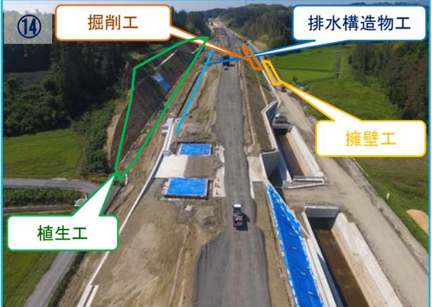
排水構造物工を中心に施工を行います。また、法面工とし植生マットの施工及び、擁壁工として重力式擁壁工の施工を行います。
