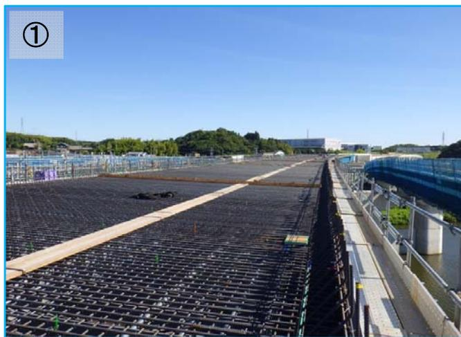
今月は、床版の鉄筋組立が完了し、コンクリートの打設を行います。
