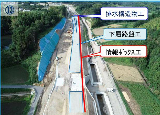
舗装工事のうち、地盤改良工事の一部が完了しました。引き続き排水構造物工、下層路盤工、情報ボックス工の施工を進めていきます。
