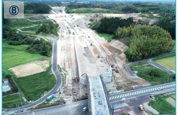
⑧ 道路土工はほぼ完了し、擁壁工、法面工、排水構造物工を引き続き施工していきます。
