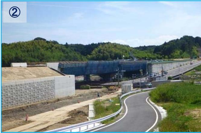
② 橋梁上部工の壁高欄コンクリートを9月初旬に打設し、付属物工終了後、9月末に足場を解体します。
