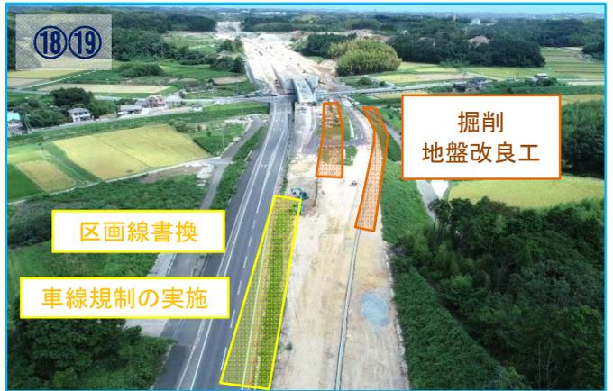
⑱ 地盤改良工が完了し、排水構造物工を施工していきます。
