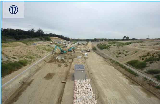
⑰ ランプから本線へと排水構造物工を引き続き施工していきます。情報ボックス工も併せて着工していきます。
