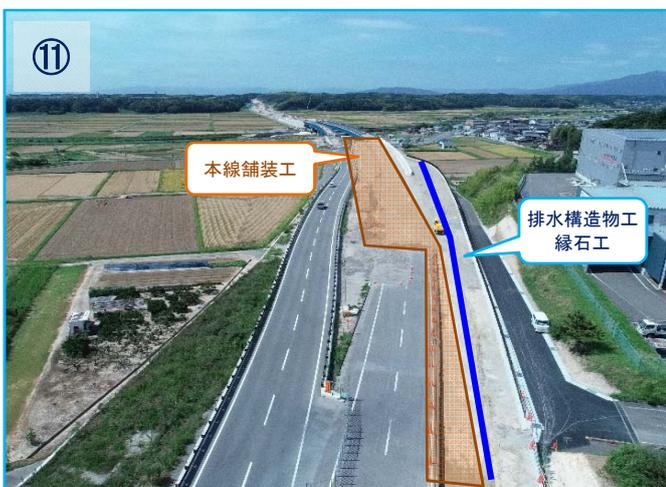
本線舗装部のセメント改良が終わり、いよいよ排水構造物に着手していきます。
