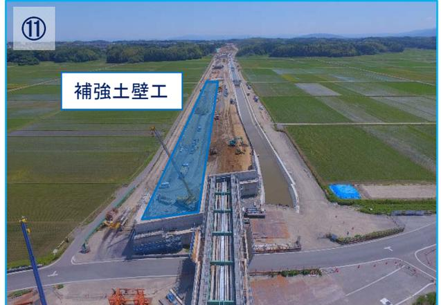
補強擁壁工及びL型擁壁工の施工を行っています。今後も擁壁工の施工を行っています。
