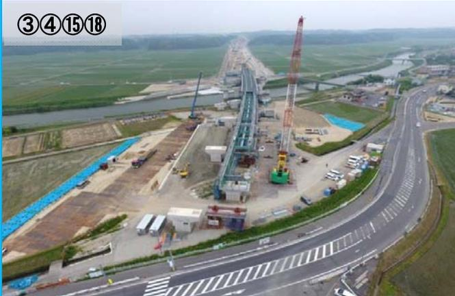
中ノ川及びオンランプ・オフランプに架ける上部構造物を製作及び施工を行っていきます。舗装工事は現在準備工の段階です。
