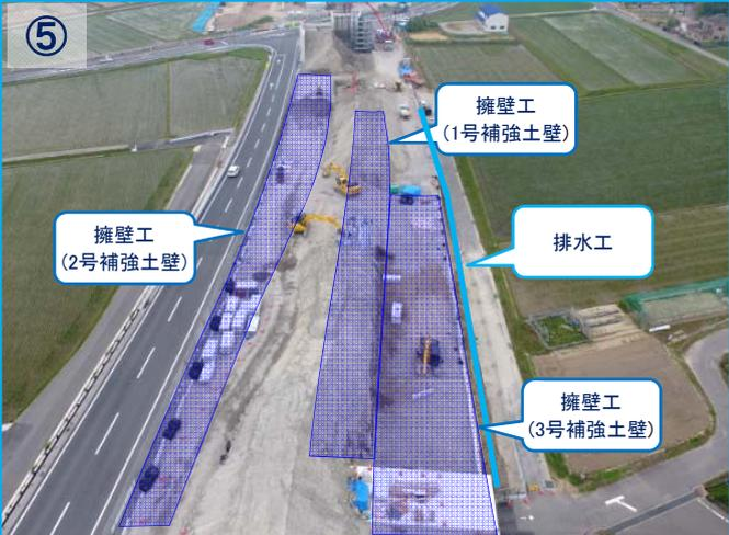
擁壁工(2・3号補強土壁)の施工及び排水工の施工を行っていきます。
