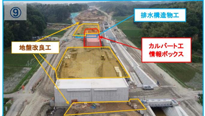
カルバート工、地盤改良工は無事完成しました。引き続き排水構造物工、情報ボックス工を行っていきます。
