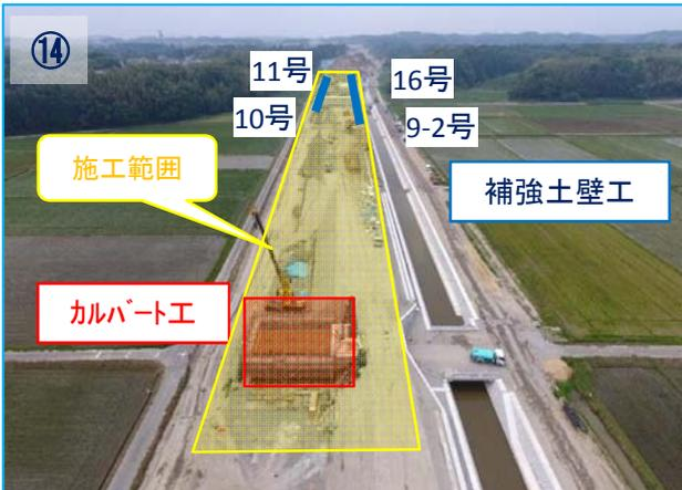
補強土壁工(9-2号、10号、11号、16号)、カルバート工施工中です。引き続き、擁壁工事及び盛土工を中心に施工していきます。
