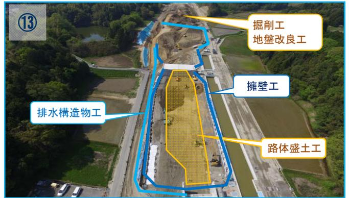
現在、盛土工、掘削工、擁壁工、地盤改良工を施工中です。新たに排水構造物工を施工していきます。
