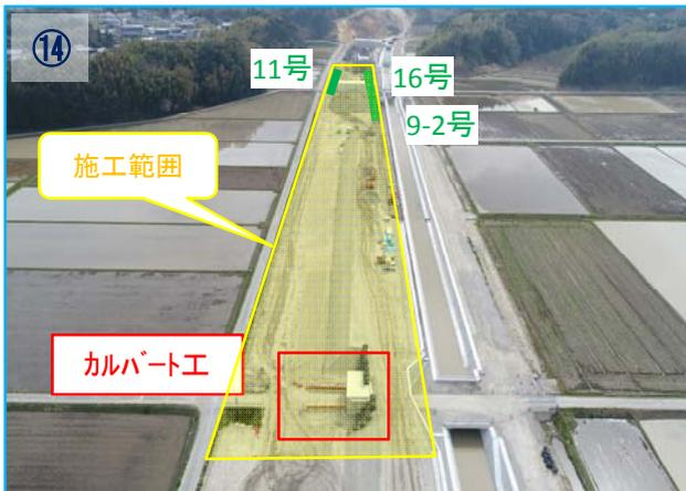
補強土壁工(9-2号、11号、16号)、カルバート工施工中です。引き続き擁壁工事及び盛土工を中心に施工していきます。
