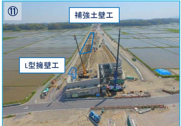
補強擁壁工及びL型擁壁工の施工を行っています。今後も擁壁工の施工を行っていきます。
