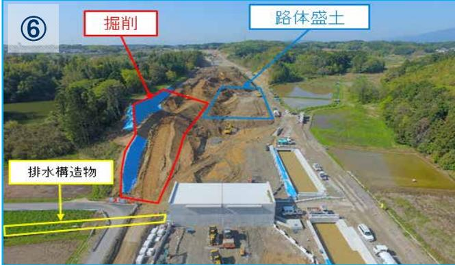
現在土工事の掘削、路体盛土を行っています。引き続き土工事を行います。5月から排水構造物を施工します。
