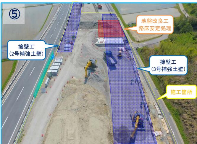
擁壁工(2・3号補強土壁)の施工及び地盤改良工(路床安定処理)の施工を行っていきます。
