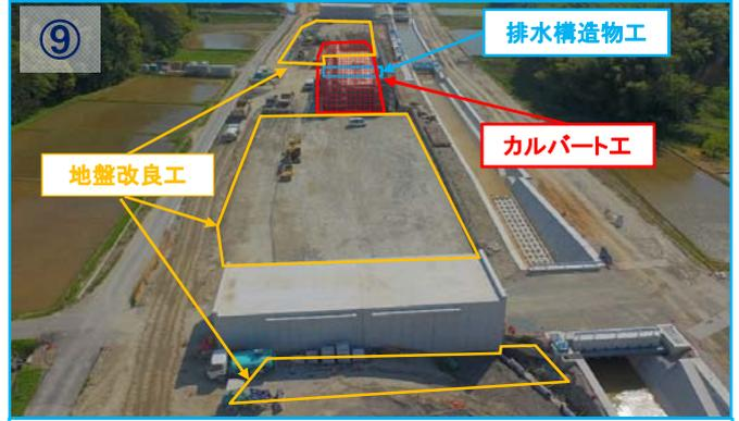
カルバート工は半分完了・地盤改良工は無事完成しました。引き続き排水構造物工を行っていきます。
