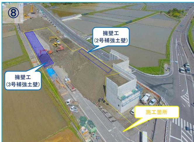
土工事及び擁壁工(2・3号補強土壁)の施工を行っていきます。
