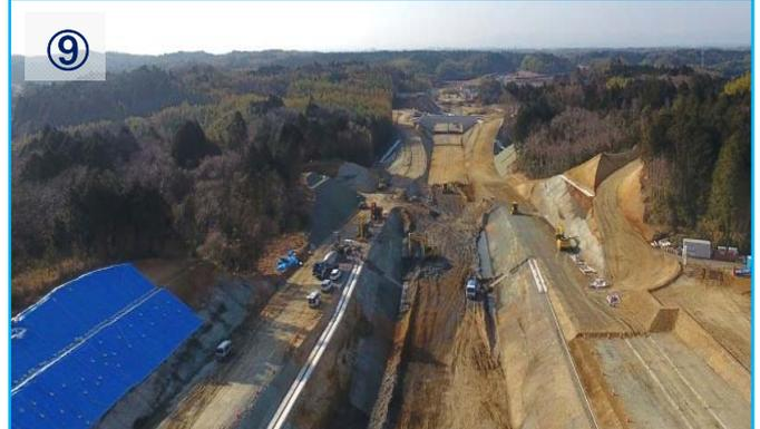
掘削工事と2月中旬より法面工(植生工)の施工を行っています。2月には掘削工事が完了し、3月中旬まで法面工(植生工)の施工を行い工事完了です。
