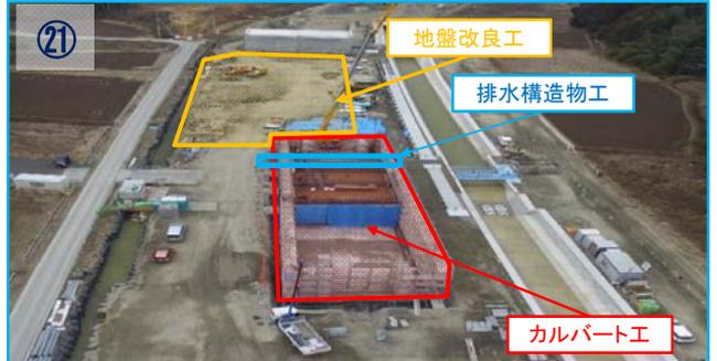
⑳3月もカルバート工の施工、地盤改良工、排水構造物工を行っていきます。
