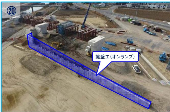
⑳ オンランプの擁壁工が完了しました。橋梁工事と調整し、6月にオフランプ側の擁壁工事を再開します。
