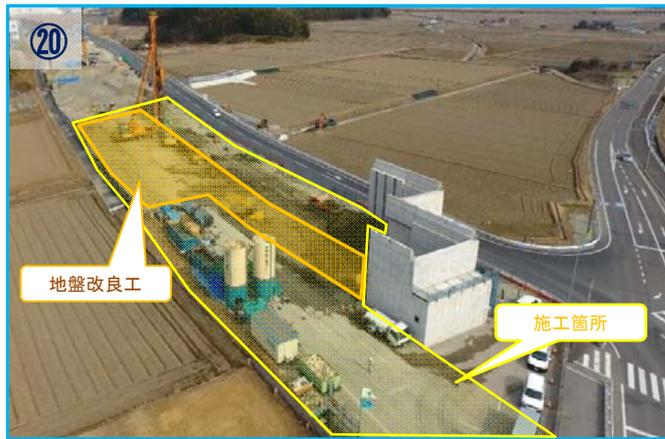
⑳ 3月上旬に地盤改良工(深層混合処理工)が完了し、順次、土工・擁壁工の施工を行っています。
