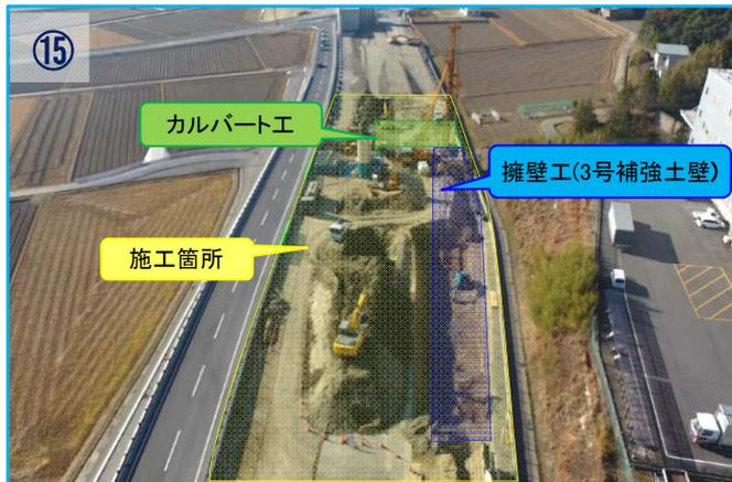
引き続き、擁壁工(3号補強土壁)の施工及びカルバート工の施工を行っていきます。
