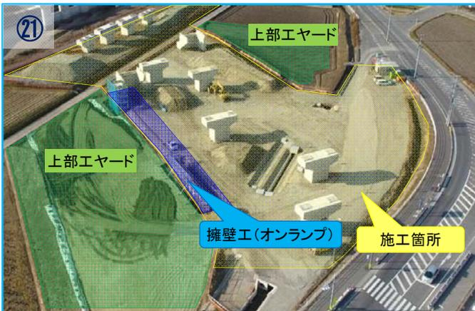
引き続き、上部エヤード(橋架設ヤード)の造成工事及びオンランプの擁壁工を行っていきます。
