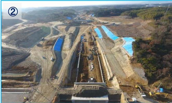
② 補強土壁の施工中です。終わり次第、排水構造物・法面整形を行います。
