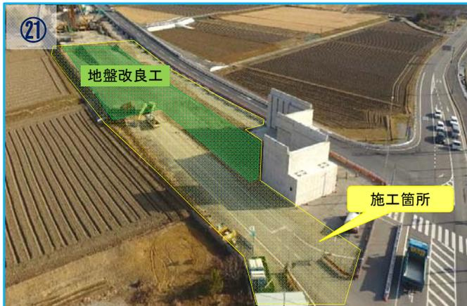
1月上旬より地盤改良工(深層混合処理工)を行っていきます。
