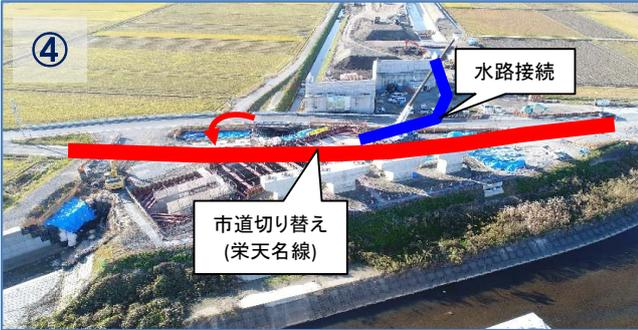
水路ボックス、ブロック積が完了しました。1月中旬に市道を切り替えた後、引き続き水路の施工を行います。
