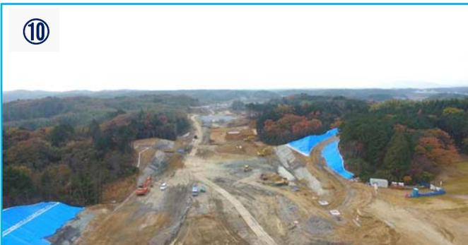
⑩ 掘削工事と排水構造物(農水管)の施工を行っています。1月の後半より法面工(植生工)の施工も行います。
