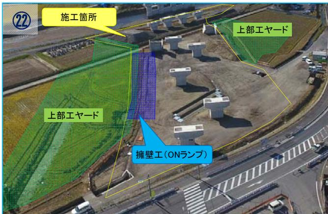
上部エヤード(橋架設ヤード)の造成工事を行い、12月中旬よりオンランプの擁壁工を行っていきます。
