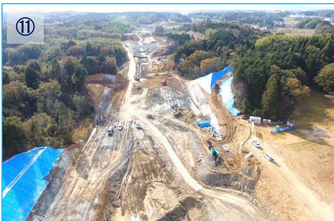
⑪ 引き続き掘削・法面整形・排水構造物(農水管)を施工を行っています。
