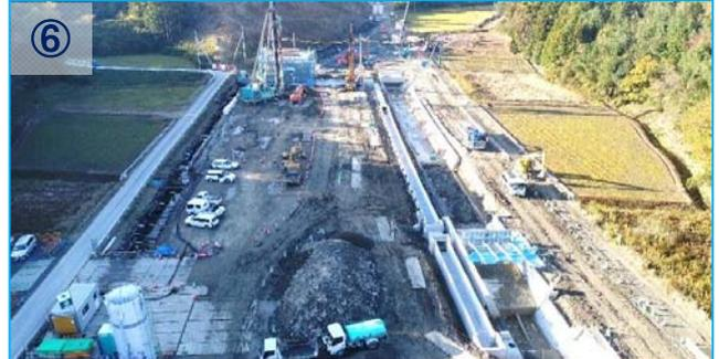
排水構造物、取水ゲートの設置が完了しました。引続き大型水路の施工をしていきます。
