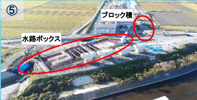
水路ボックスは約1/2完了。引き続き水路ボックスとブロック積みの施工を行っていきます。
