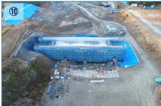
⑩ カルバート工の施工が完了し、道路土工、擁壁工を行っています。
