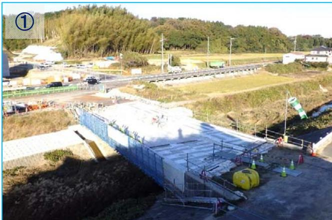
① コンクリート施工が完了し引き続き橋梁の両脇に防護柵・欄干を取り付ける作業を行います。
