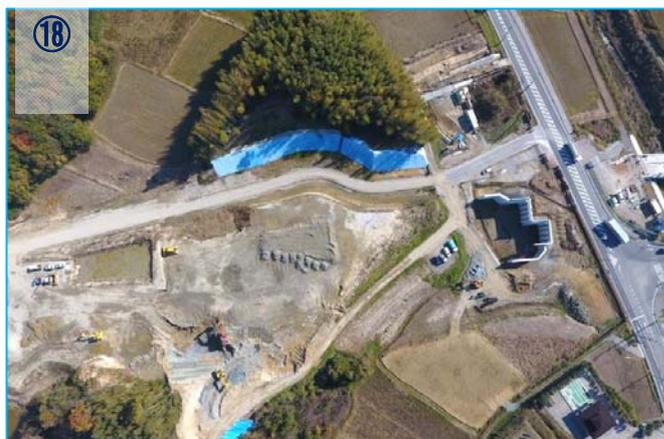
⑱ 付替道路となる箇所、掘削工事を行い擁壁と排水構造物を施工しています。
