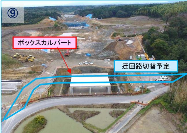
カルバート工の施工が終わり、道路土工(掘削)及び埋戻しを行い、市道の切替えをする予定です。
