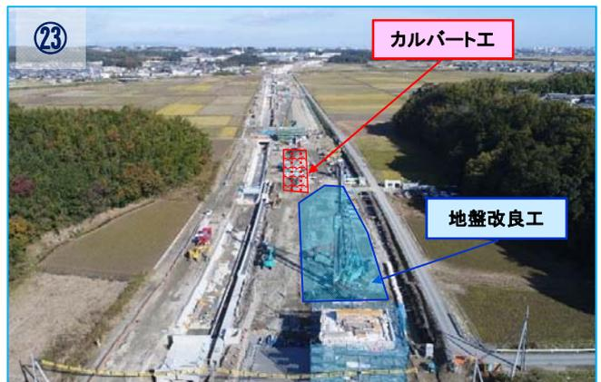
地盤改良工の施工をしています。1月よりカルバート工の施工する予定です
