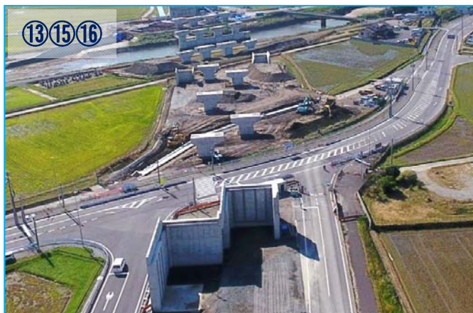
中ノ川及びオンランプ・オフランプに架ける上部構造物を製作中です。
