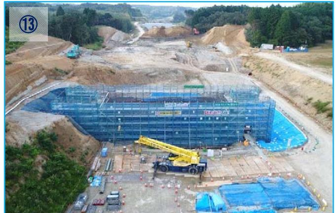
⑬ カルバート工の底版コンクリートを完了し、壁、頂版の施工を行っております。
