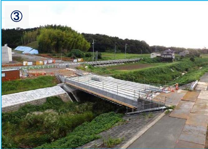
③ 9月にコンクリートの橋桁が架かりました。現在の状況は、橋桁全体を一体化させる作業をしています。
