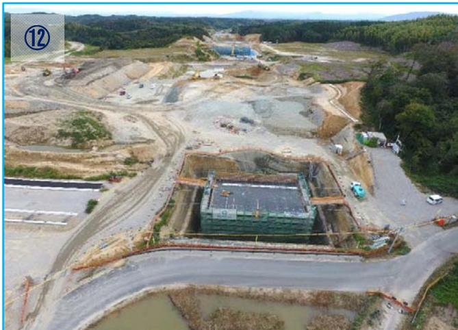
⑫ カルバートの施工と道路土工(掘削作業)を行っています。
