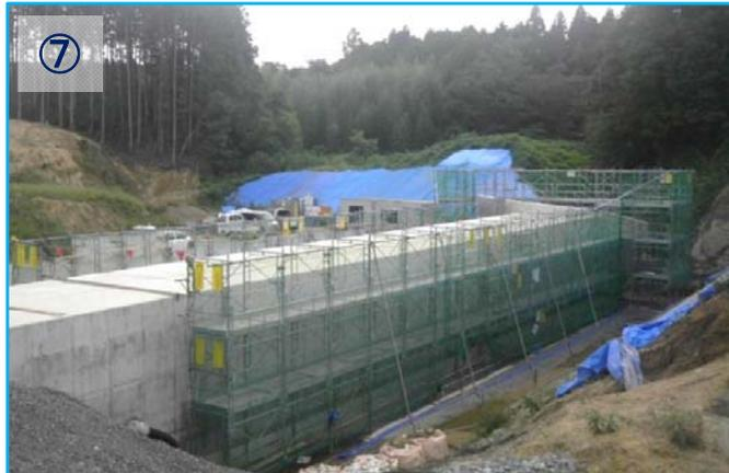
⑦ カルバート工を施工しています。10月中旬より、カルバート工周囲の盛土工事を施工する予定です。
