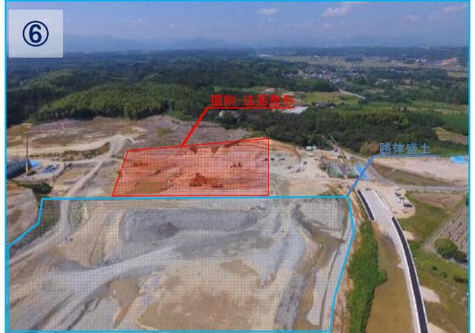
⑥ 掘削・路体盛土・法面整形を施工しています。
