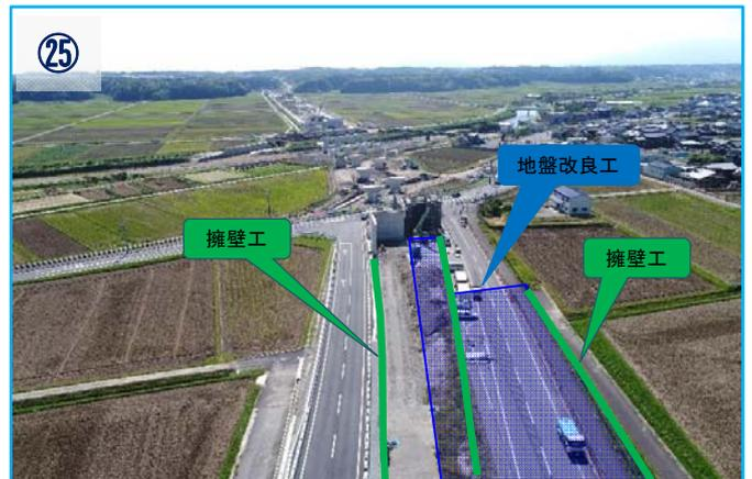
10月下旬より、土工・地盤改良工及び擁壁工と順次、工事を進めていきます。
