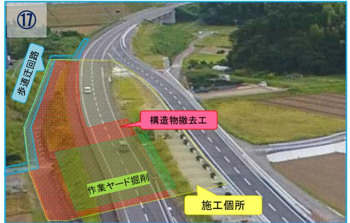
10月中旬より歩道を迂回させて頂き、構造物撤去工・仮設工(作業ヤードの掘削)を行っていきます。
