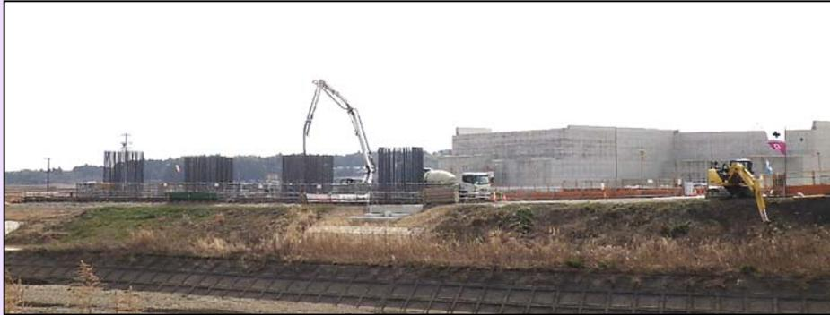
中ノ川右岸(津市側)にて中ノ川高架橋の橋脚工事をしています日本土建(株)です。現在、地下(鋼矢板内部)で躯体工事をしており、柱部分の姿が見えてきました。工事期間中はご迷惑をお掛けしますが、ご理解とご協力をお願いします。
