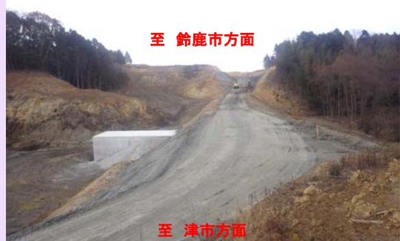
中勢バイパスの工事をします三重農林建設(株)です。工事内容は三行地区で、区間の約0.9kmの工事用道路を作る作業していきます。現在は、道路土工の作業(掘削・盛土)を行っています。工事は3月初旬完成予定です。安全第一で進めていきますので、よろしくお願いします。
