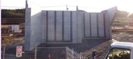
本線(上下線)A1橋台
