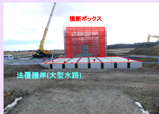
市道御薗125号線(本線NO.372付近)
