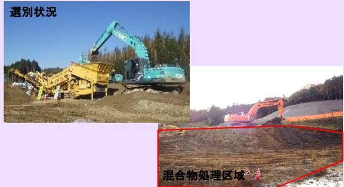
中勢バイパスの道路建設工事を行っています。11月より混合物処理工を着手しました。12月上旬より道路土工(土砂掘削・盛土工)の施工も始まりました。隣接する工事もありますので、調整しながら安全には十分注意して進めていきます。宜しくお願い致します。
