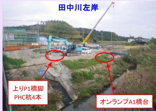
現在、本線(上下線)A1橋台の躯体の施工を行っております。11月上旬頃に上り線のコンクリート打設が終了し、中旬以降に下り線のコンクリート打設予定です。
