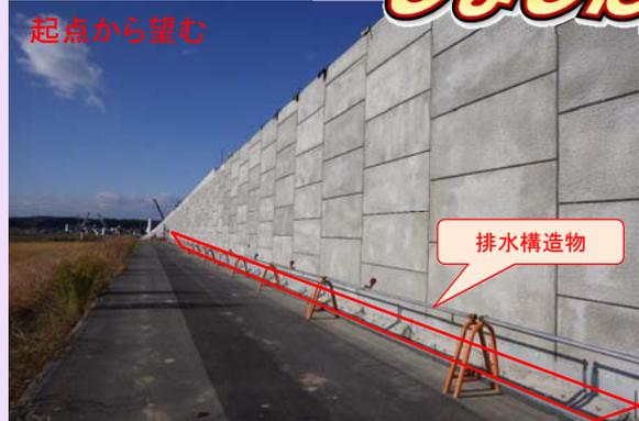
現場は地盤改良と道路土工(掘削・盛土)の施工を並行して行っており、その後、市道側の排水構造物を施工し、現場内の整地・片付けを行い、工期である11月25日に工事完成致します。
