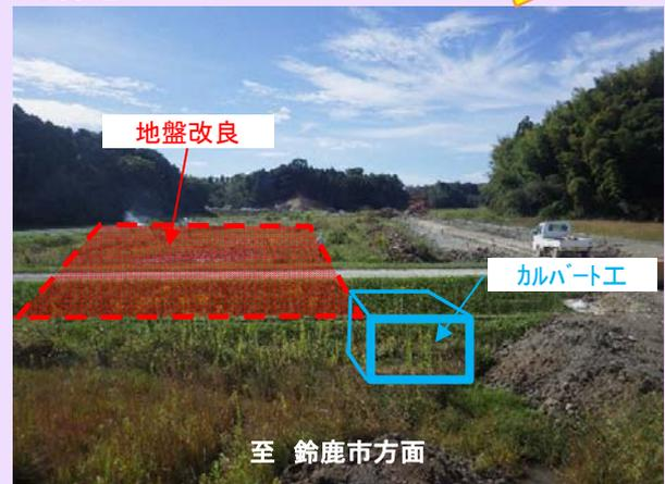
中勢パナソニックの越知地区道路建設工事をを行います(株)森組です。工事内容は地盤改良工と水路のカルバートを施工します。工事は安全第一で施工致しますので、ご理解とご協力を賜りますようお願い致します。
