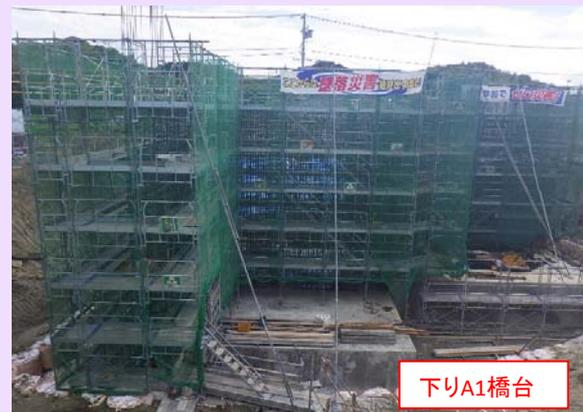
現在、本線(上下線)A1橋台の躯体の施工を行っております。9月中旬に縦壁コンクリート打設を行い、10月以降は、縦壁及び胸壁の施工を予定しております。10月中旬より田中川左岸の上り線P1橋脚におけるPHC杭の施工を予定しております。
