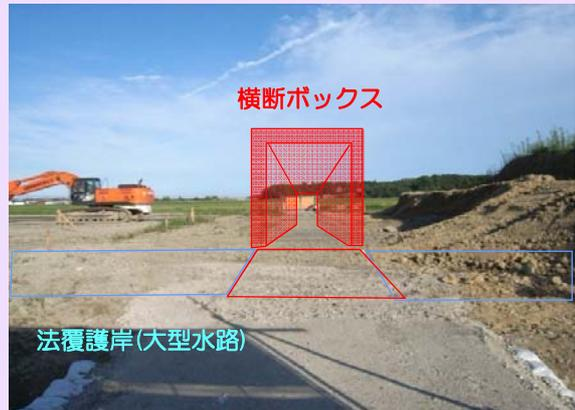
現在、道路土工として掘削・残土搬出及び大型水路の施工を行っています。
