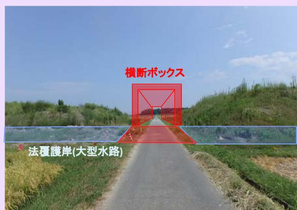
現在、道路土工として掘削、残土搬出を行っています。また大型水路も施工開始しました。今後は、表層安定処理の施工と順次、行っていく予定です。**8月下旬から市道御薗125号線を通行止め**させていただき、本線横断のボックスカルバートの施工を行う予定です。
