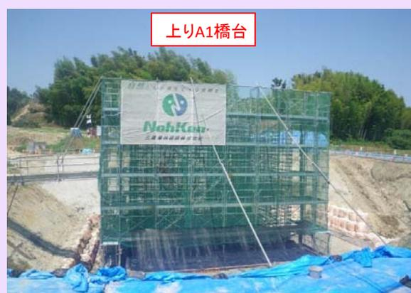
現在、本線(上下線)A1橋台の躯体の施工を行っております。8月中旬に底版のコンクリート打設を行い、9月以降は、豎壁の施工を予定しております。10月中旬より田中川左岸の上り線P1橋脚におけるPHC杭の施工を予定しております。引き続きご協力よろしくお願い致します。
