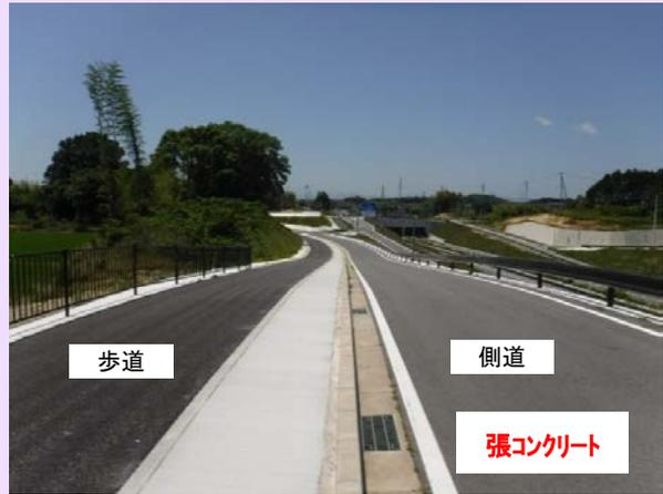
側道各所において張コンクリート(防草対策)、排水工・防護柵及び歩道・車道舗装です。引き続き施工しております。
