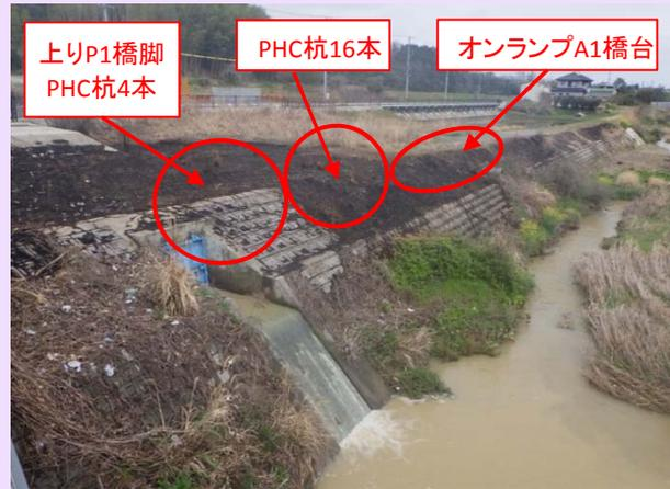
中勢パル入津市河芸町三行工区において橋台工・橋脚工を行います三重農林建設(株)です。6月から市道の切り廻し道路及び作業ヤードの整備を施工してます。6月中旬以降は橋台の掘削作業となり、7月中旬頃から躯体の施工を予定しています。ご協力の程宜しくお願いします。
