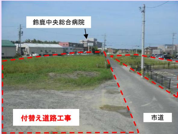
主に鈴鹿中央総合病院南側の鈴鹿市安塚町地内にて、市道切替前の付替え道路工事における、排水工・地盤改良工及び車道舗装工事です。
