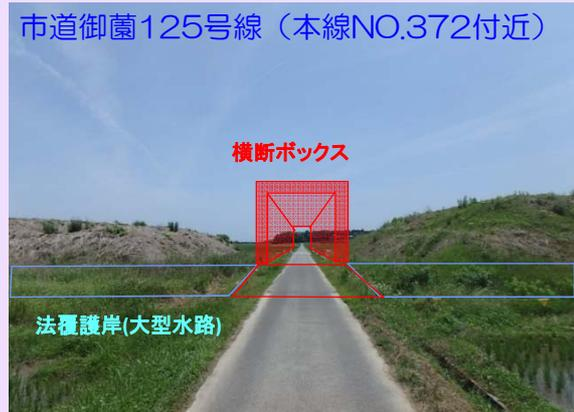
現在、仮水路工として排水路の切廻し工事を行っています。その後、道路土工として掘削、大型水路・表層安定処理の施工を順次行っていく予定です。また8月下旬からは市道御園125号線を通行止めさせて頂き本線横断のボックスカルバートの施工を行う予定です。地域住民の皆様には大変ご迷惑をおかけしますがご理解とご協力をお願い致します。
