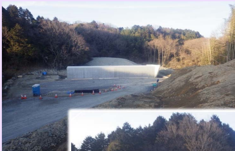
ボックスカルバート施工箇所
