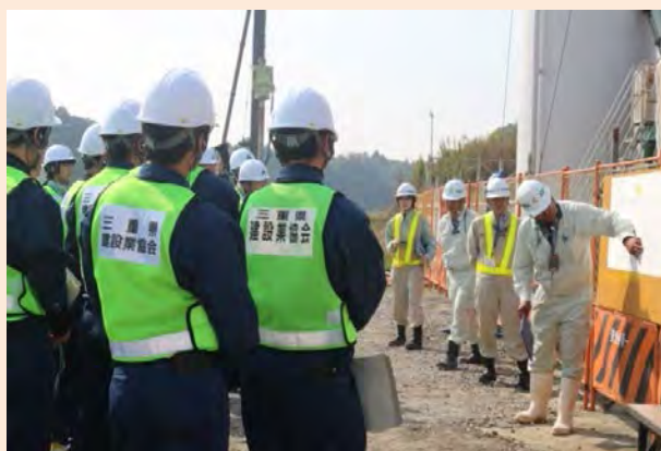
地盤改良工の説明を聞く学生
