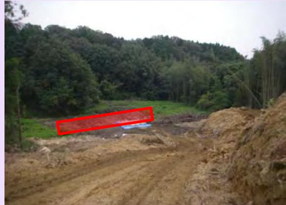
中勢バイパスの整備工事をします三重農林建設です。工事は安全第一で進めていきますので、よろしくお願いします。工事内容は三行地区で区間約0.6kmの工事用道路作る作業していきます。現在、工事用道路を作る為の伐採作業とボックスカルバートの作業ヤードの整備行っています。10月中旬以降に掘削・土の搬出を予定しています。
