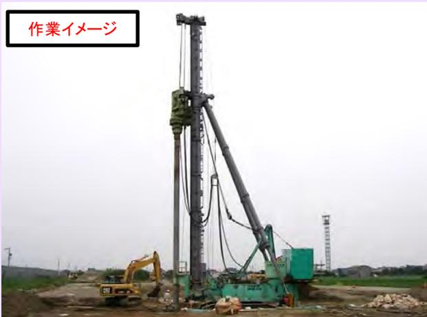
(株)アイケーディです。軟弱地盤を改良する工事と市道栄天名線(中ノ川の右岸堤防道路)の切替工事を行っていきます。地盤改良工は8月下旬から施工を行う予定です。改良にあたっては粉塵等には十分気をつけて施工してまいります。市道の切替工に関しては一部交通規制をかけさせていただきます。事故のないように努めていきますのでご協力お願い致します。
