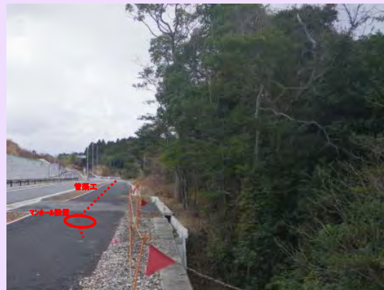
道伯稲生線交差点付近
