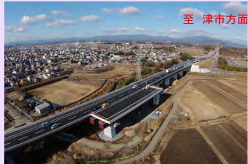
開通後 相川高架橋上空から撮影
