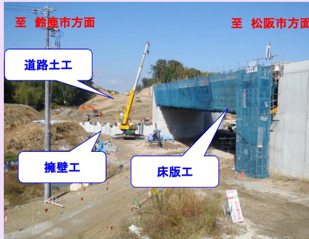
中勢BP(神戸～半田区間)にて道路土工、擁壁工、床版工の施工を行っています。引き続き、道路土工(盛土)、擁壁工、排水構造物工の施工を進めて行きます。
