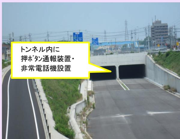
中勢バイパスのトンネル防災設備(押ボタン通報装置・警報表示板・非常電話機)及び道路情報板を設置する工事です。1月中旬に工事完成予定です。
