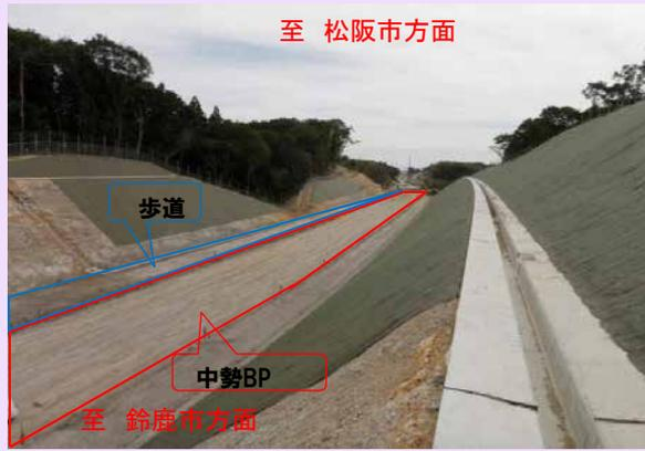
中勢バイパス開通に向け、本線、側道の盛土を進めています。法面工、擁壁工と順次進めていきます。
