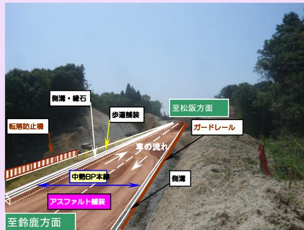
中勢バイパスと県道雲出野田バイパス(将来)が立体交差する箇所より松阪市側の約1.1kmの排水構造物と情報ボックスを施工中です。今後は、防護柵工、本線にてアスファルト舗装工、区画線等の工事を順次進めていきます。
