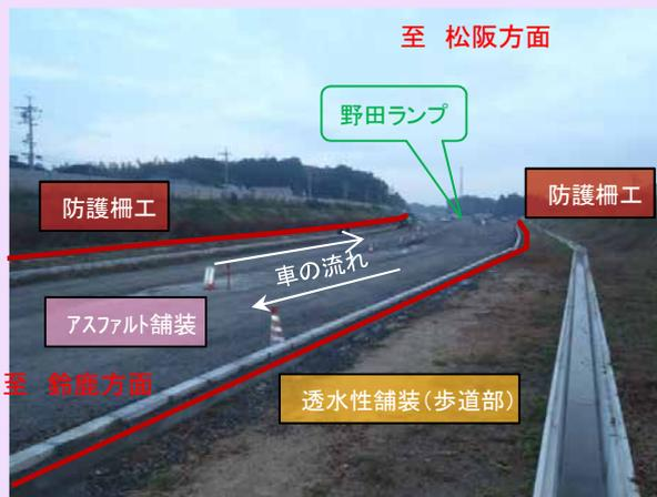
現在、県道家所阿漕停車場線から緑が丘間の約900mにおいて、側溝・ブロックの設置・舗装工事を進めております。今後、野田交差点での作業が多くなっていきます。安全第一で作業を進めてまいります。工事期間中は交通規制等にて、ご迷惑をお掛けしますが、ご理解とご協力お願いいたします。
