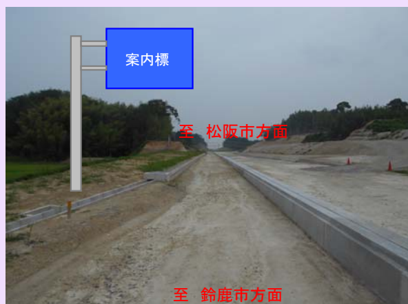
本線NO.1182付近
