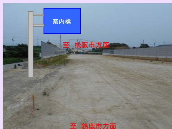
本線NO.1228付近
