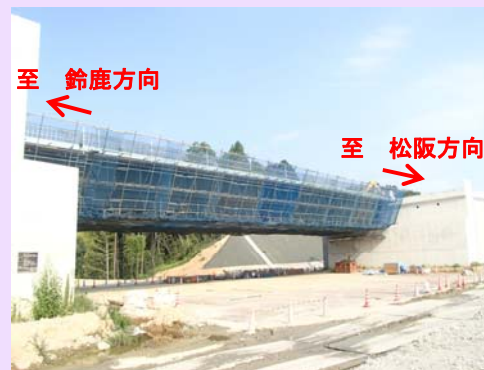
中勢バイパス上り側道から南側を見る
