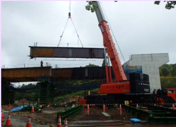
大型クレーンによる架設状況
