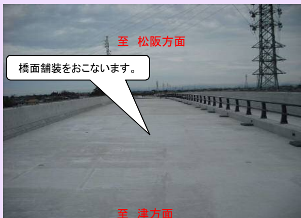
相川高架橋から撮影
