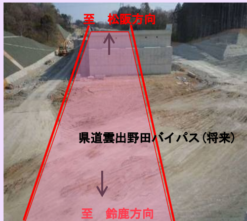
中勢バイパス本線橋台から南側を見
