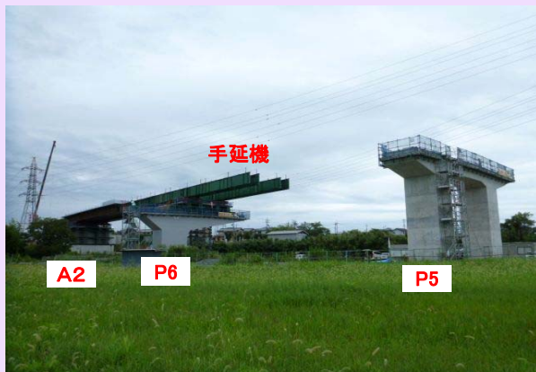
相川高架橋を北側よりみたところ
