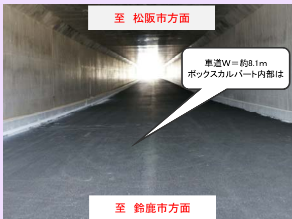
ボックスカルバート内部
