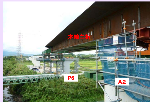
相川高架橋を西側よりみたところ
