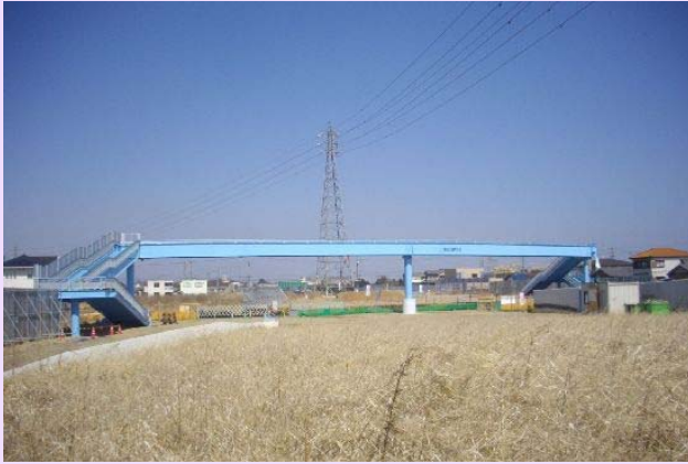
中勢バイパス 松阪方面より見る
