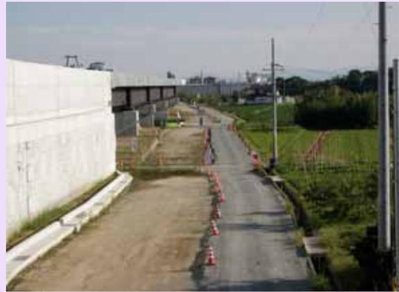
側道を雲出川より伊勢方面に向けて施工中です。現在、路床を仕上げています。
