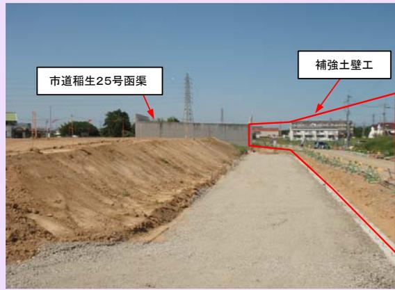
補強土壁の施工を行います。コンクリートのパネルを構築しながら、約6m盛土を行います。
