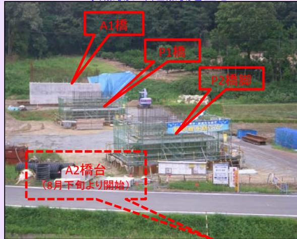
橋梁下部工の今後の工程は、各構造物の構築と仮設工の撤去、A2橋台は8月の稲刈り終了後より構造物の構築を開始します。
