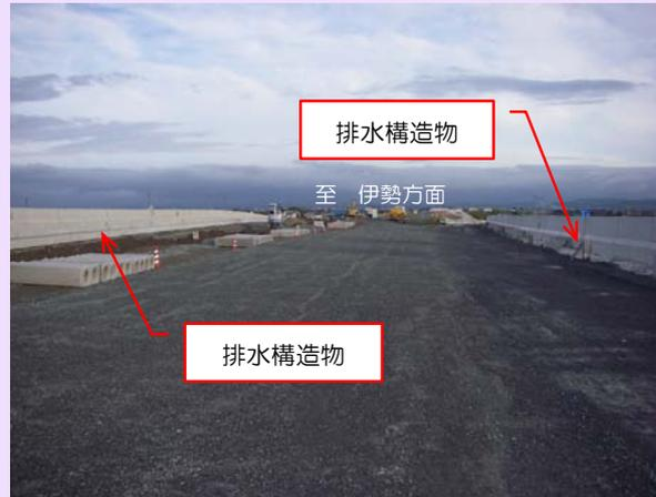
本線の排水構造物と路肩盛土を施工中です。引き続き縁石工(道路端のコンクリートブロック)や情報BOX(通信用のケーブルを入れる専用の配管)を予定しています。
