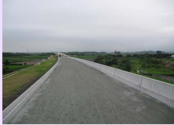
本線の一部で路盤を順次仕上げています。アスファルト舗装も 雲出川から国道165号に向け路盤材の敷均しをしています。今後行っていきます
