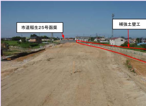
本線部分の盛土を施工中です。市道稲生25号函渠の上をバイパス本線が通るように、盛土を行っています。
