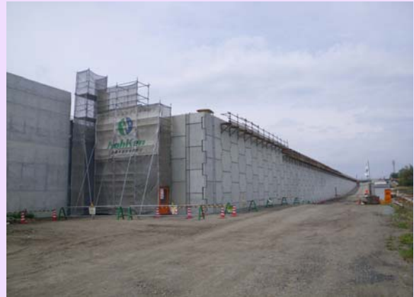
木造側から(現況)
