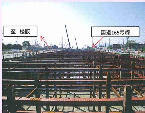
10月より国道165号線から県道にかけてトンネル(函渠)工事を開始しました。
