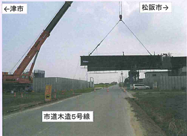
鋼桁架設状況
