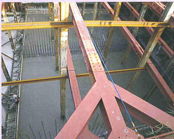
トンネル(函渠)の底版部コンクリート打設をしたところです。
