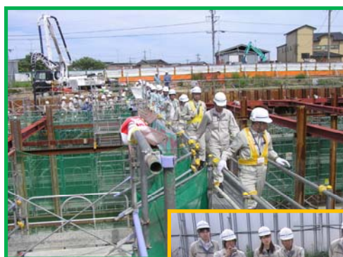
U型擁壁の コンクリート打設 を確認
