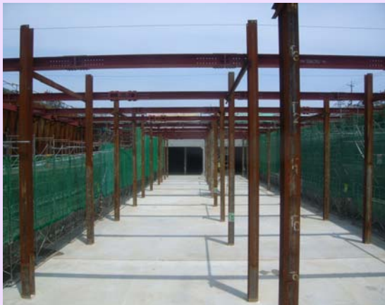
道路トンネル入口
