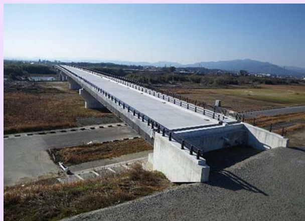
雲出川左岸側(津市側)
