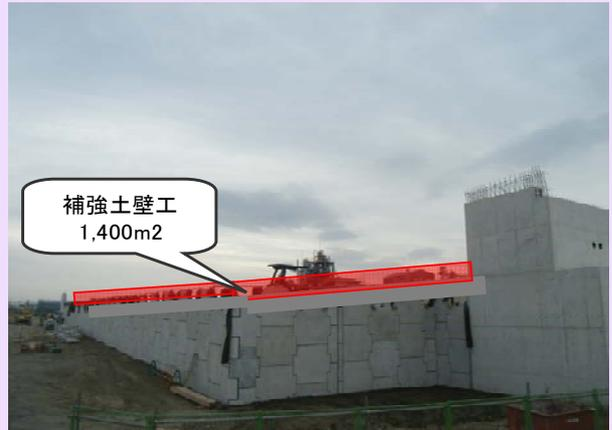
7割ぐらいが完了し色彩部の施工のみとなりました。終わり次第、剛性防護柵工の施工に着手します。
