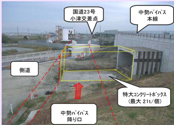
中勢ハイパス終点(小津交差点)への降り口を施工中です。特大のコンクリートボックス(3個/組)を14組(14m)設置して側道部の連絡路を構築していきます。
