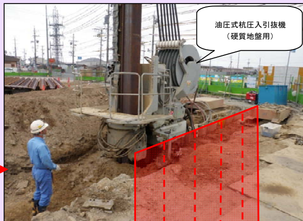
鋼矢板圧入状況
