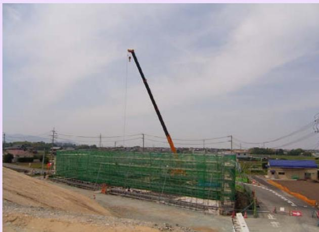
市道牧木造線の横断函渠を施工中です。現在底版の施工中で、引き続き、壁・頂版と進めていきます。
